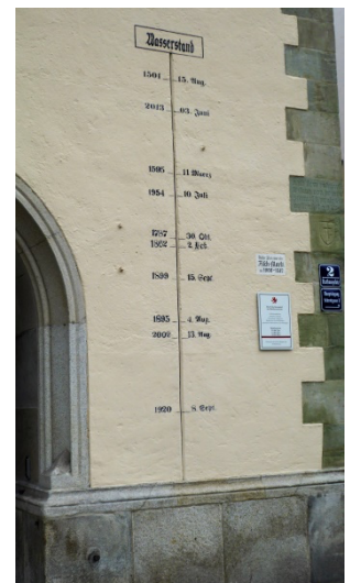
Abbildung 4: Hochwassermarken in Passau Bereits zwei Markierungen in diesem Jahrhundert.
